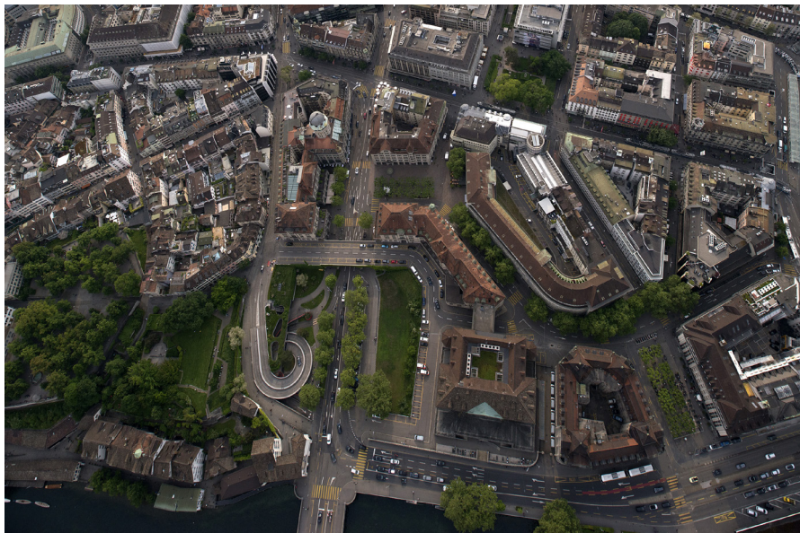
Luftbild Zürich-Altstadt mit der Lindenhofbrücke und dem Amtshaus III
